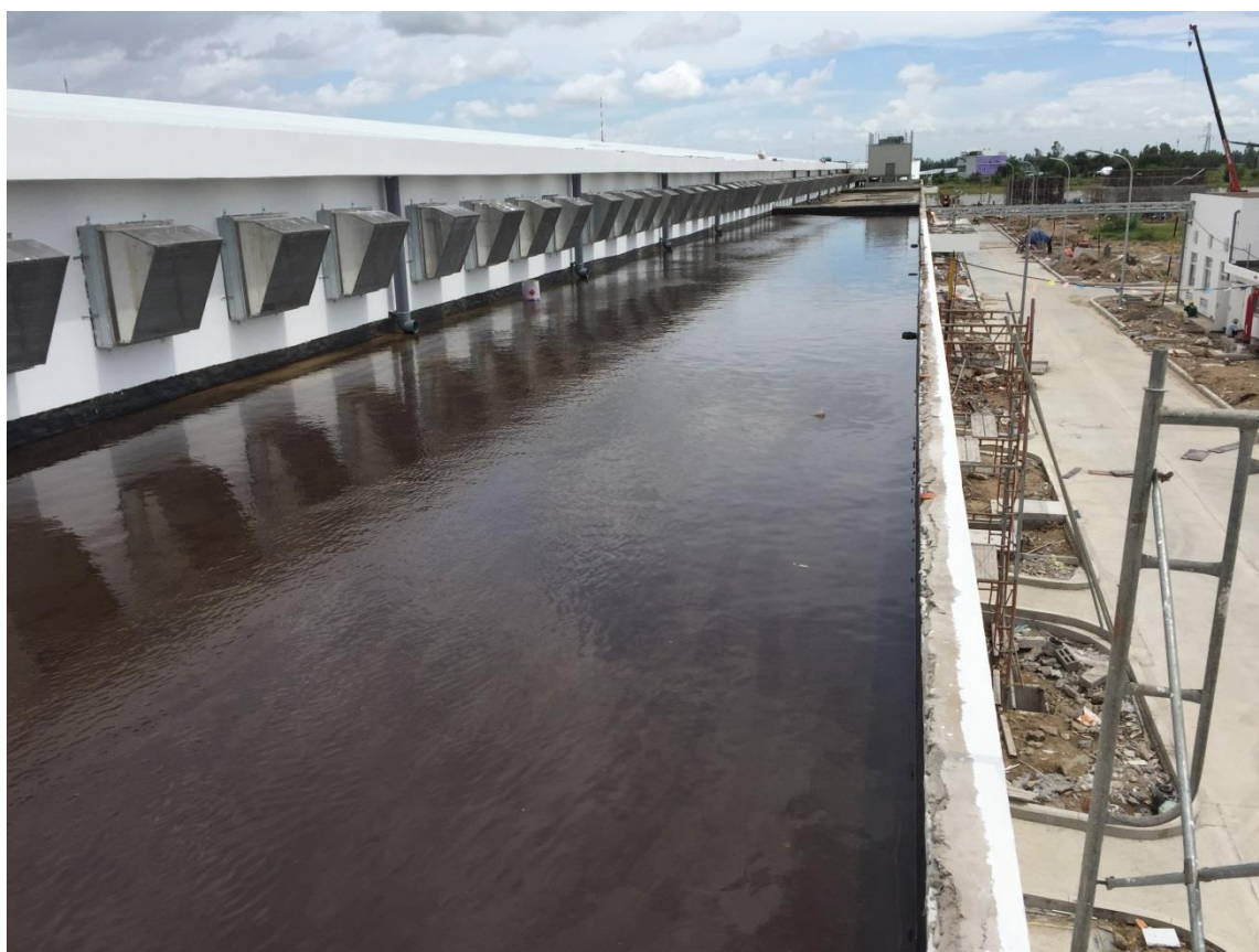
Kiểm tra thẩm trước khi thi công lớp phủ bảo vệ
