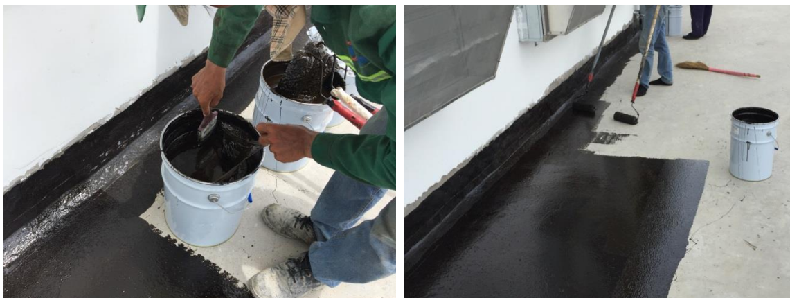
Thi công lớp lót, lớp phủ Sikalastic®-680 AP bằng cọ hoặc con lăn
