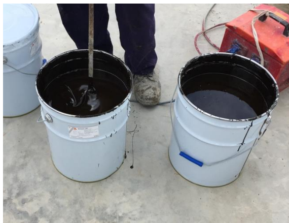
Khuấy đều vật liệu bằng cần trộn trước khi thi công
