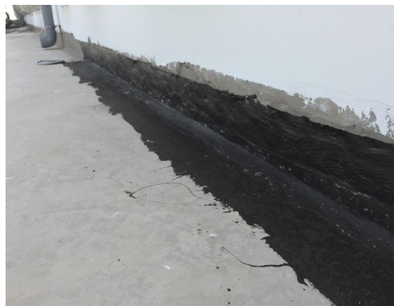
Thi công các chi tiết trước (góc cạnh, mặt đứng, v.v..)
